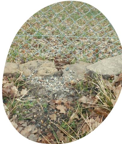
Pour assurer le passage de la petite faune à travers les clôtures en grillage, de simples découpes et creusements dans le sol ont été réalisés. Des pierres matérialisent le passage et limiteront le comblement par les feuilles, pierres et débris divers.
