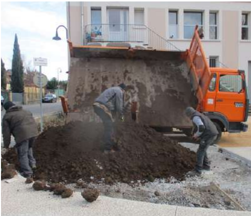
Remplissage des massifs en terre en régie
