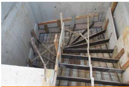
Coffrage pour escalier
