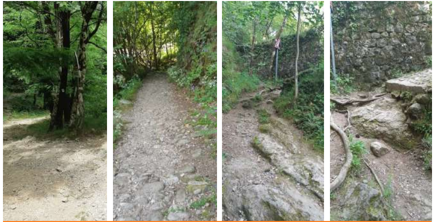
La situation des calades et de l'accès au pont avant les travaux
