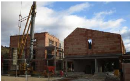
Réalisation des pignons
