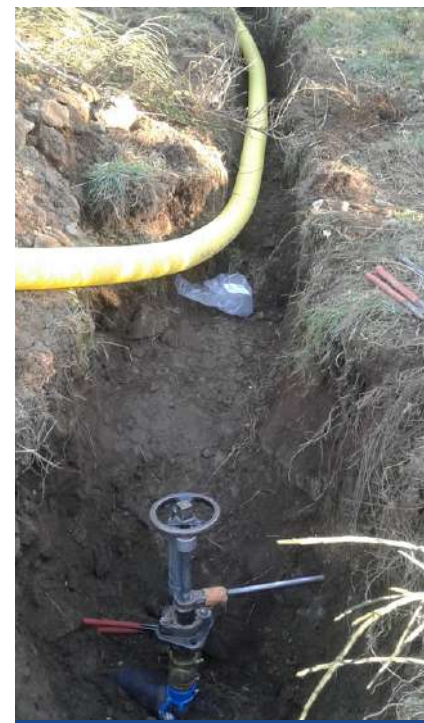
Prise en charge sur tuyau fonte
