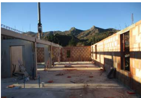
Vue intérieure de 1er étage
