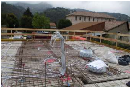
Préparation du coulage de dalle
