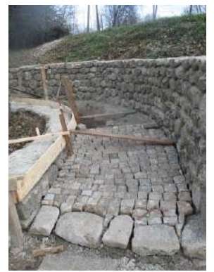
Coulage de la couvertine
