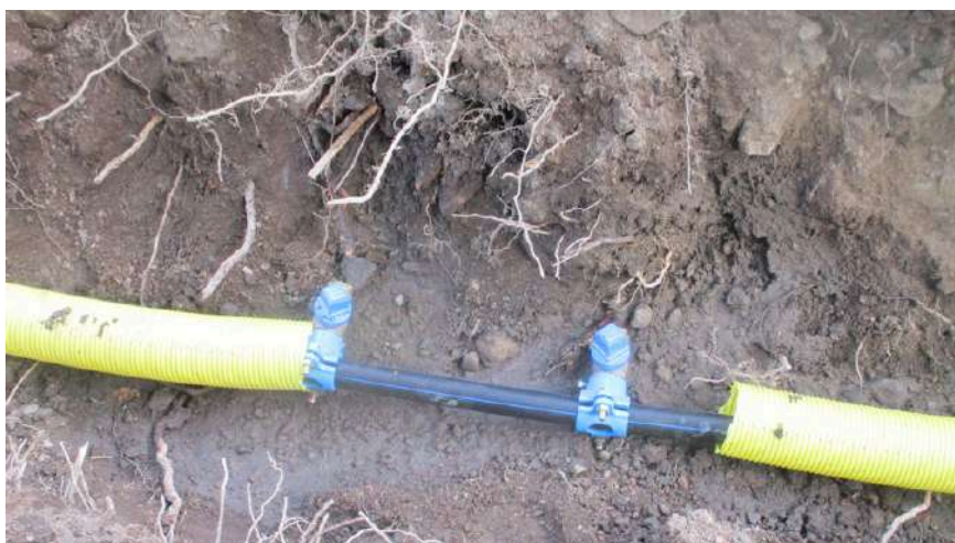
Prise en charge de deux branchements
