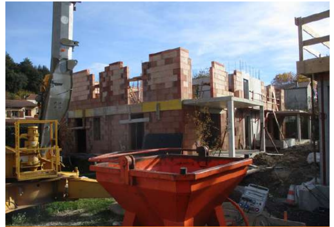
Montage des briques du 1er étage
