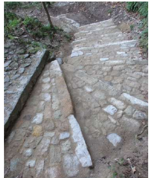
Création d'un escalier tournant en balancier
