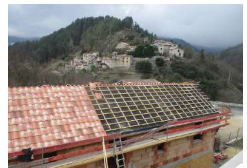
Pose des tuiles
