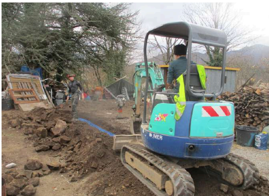
Fermeture de tranchée
