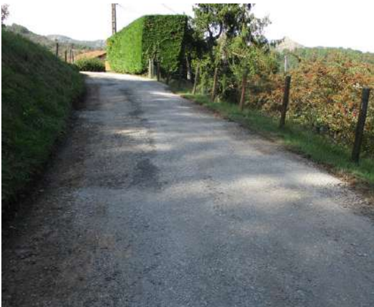
Chaussée compactée
