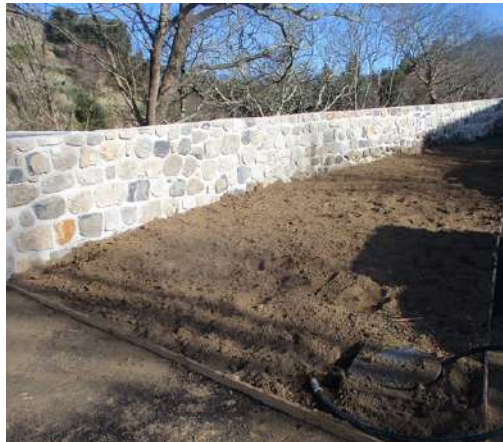
Remplissage des massifs en terre en régie
