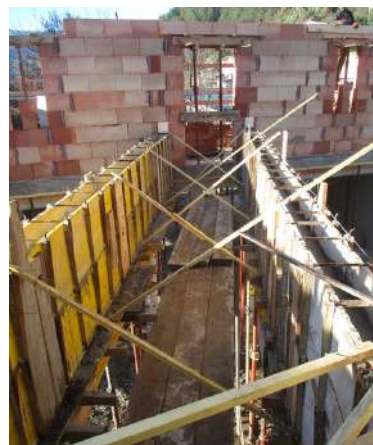
Passerelle entre les deux bâtiments
