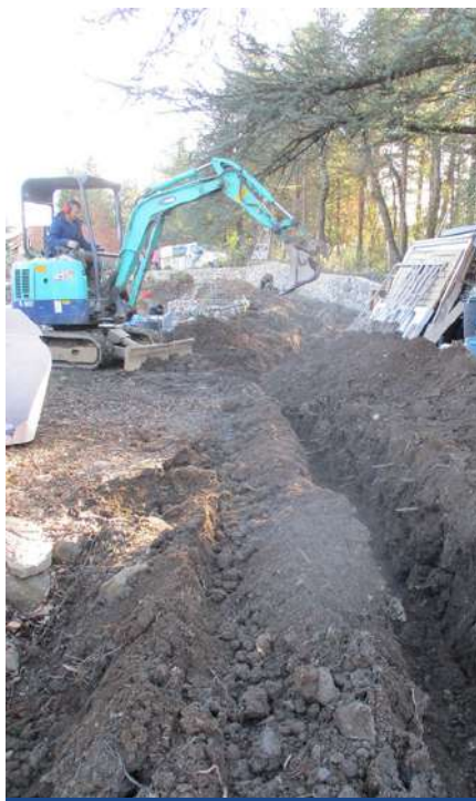
Ouverture de tranchée
