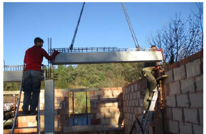
Pose de poutres sous dalle préfabriquées
