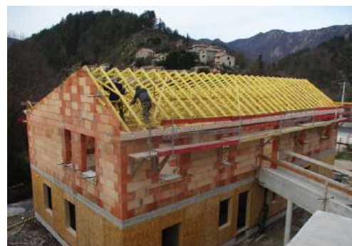
Pose des fermettes
