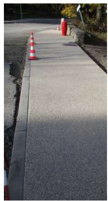
Places de stationnement avec basaltes, porphyre et pouzzolane
