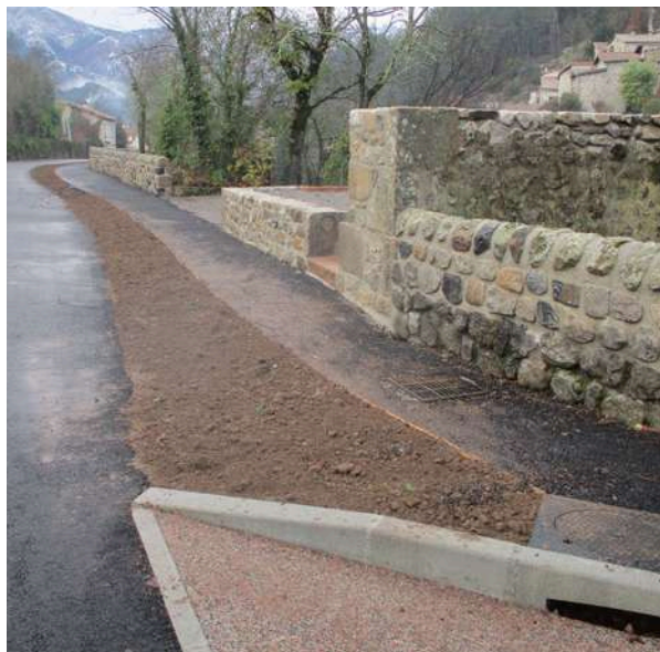
Remplissage des massifs en terre en régie
