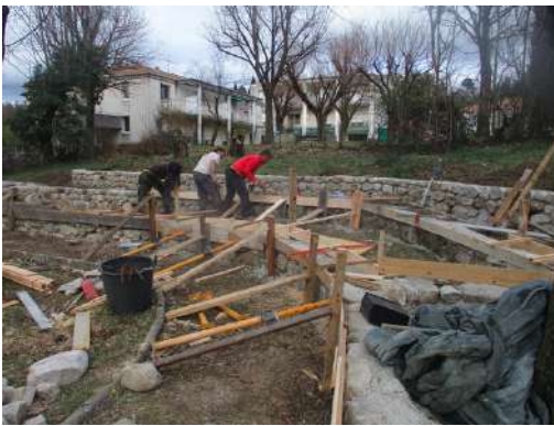
Coffrage de la couvertine
