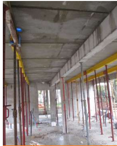
Pose de pré-dalles
