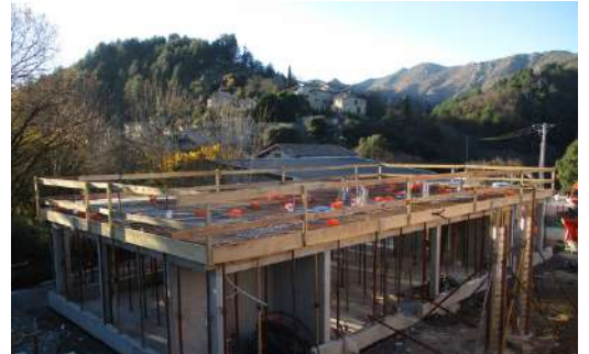
Préparation du coulage de la dalle d'un étage
