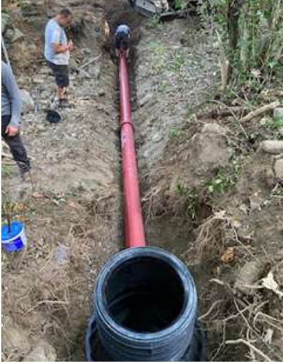
Traversée de ruisseau et bétonnage de la traversée
