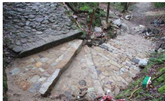
Création d'un escalier tournant en balancier
