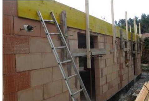
Création d'un chaînage périphérique
