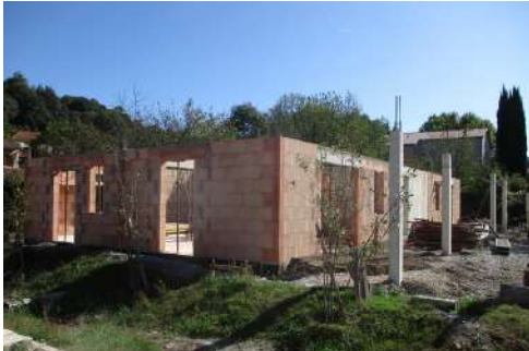
Montage des murs en brique
