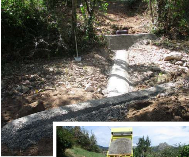
Traversée de ruisseau et bétonnage de la traversée
