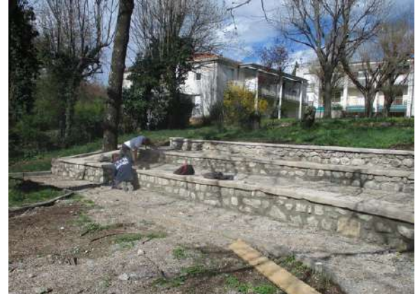
Jointage des gradins
