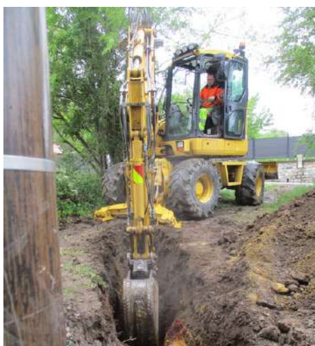
La reprise d'un réseau d'eaux usées aux Sausses
