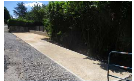
Réalisation d'un nouveau parking
