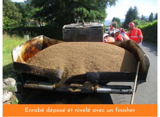
Revêtement en brique concassée et pouzzolane
