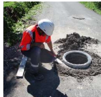
Mise à la côte de regards d'assainissement et de chambres de tirage
