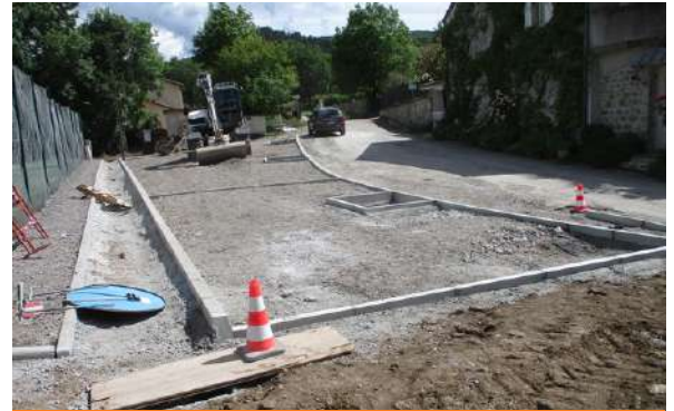
Nivelage du nouveau parking du city stade et création d'une noue
