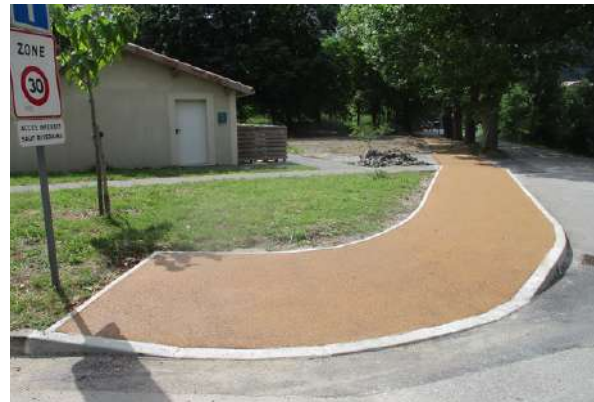
Réalisation des trottoirs en enrobé coloré
