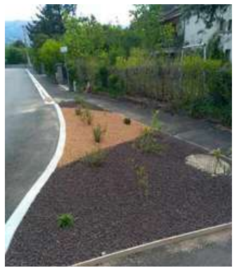
Revêtement en brique concassée et pouzzolane
