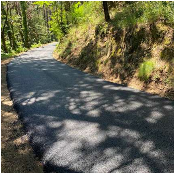
Goudronnage en enrobé de la route du Fau
