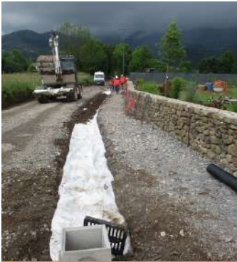
Réalisation d'espaces verts et de drains pour améliorer la rétention des eaux pluviales
