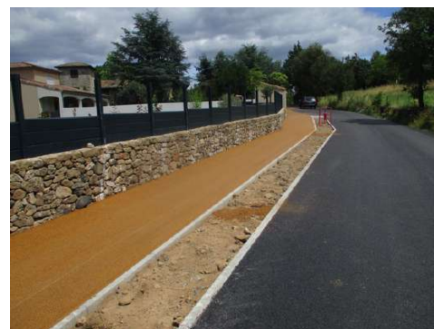
Réalisation des trottoirs en enrobé coloré
