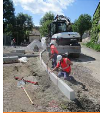
Pose de bordures
