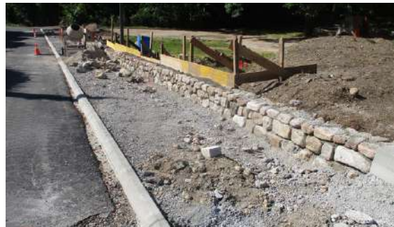
Réalisation d'espaces verts et de drains pour améliorer la rétention des eaux pluviales
