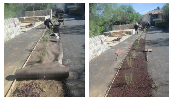
Pose de géotextile et de pouzzolane
