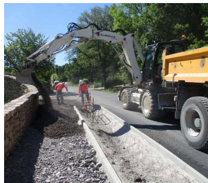
Mise à la côte de regards d'assainissement et de chambres de tirage
