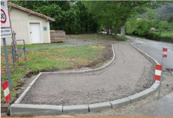
Pose de bordures et création de trottoirs
