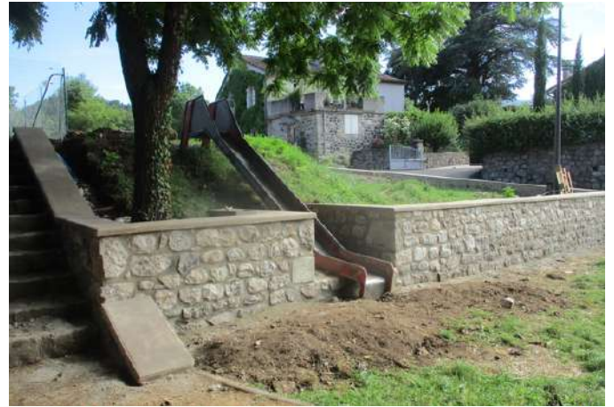
Surrélévation du mur existant
