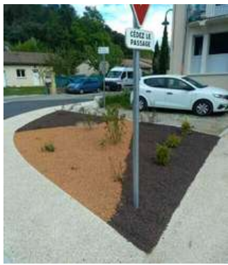
Revêtement en brique concassée et pouzzolane
