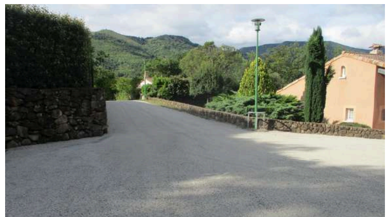
Goudronnage en bicouche de l'impasse de la Bastide (2ème et dernière tranche)
