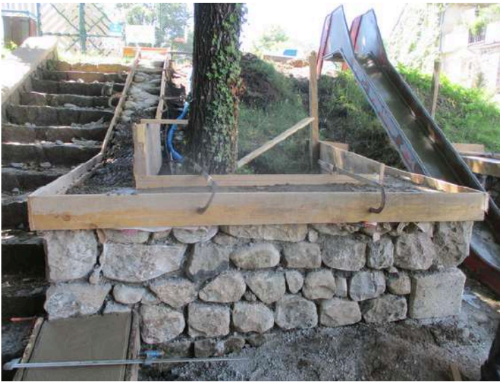
Surrélévation du mur existant
