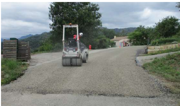
Goudronnage en bicouche de l'impasse de la Bastide (2ème et dernière tranche)
