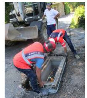
Mise à la côte de regards d'assainissement et de chambres de tirage
