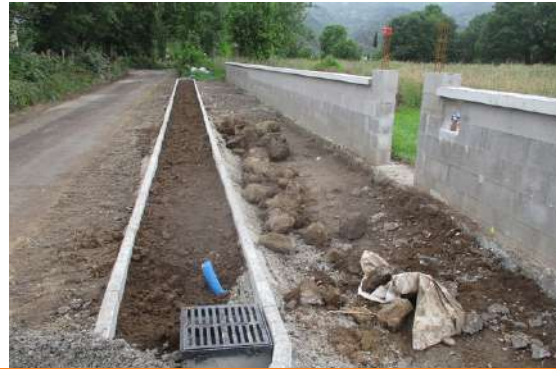
Réalisation d'espaces verts et de drains pour améliorer la rétention des eaux pluviales
