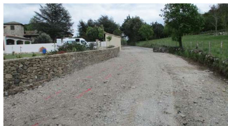
Creusement du rocher pour élargir le cheminement piéton
